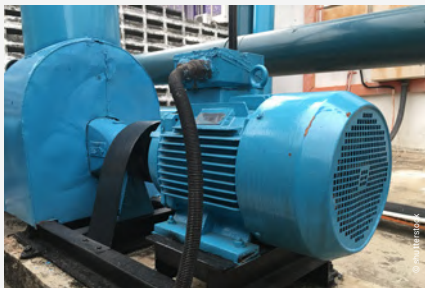
Fig. 12: Actionneurs typiques : système hydraulique, ventilateur et vanne de régulation
